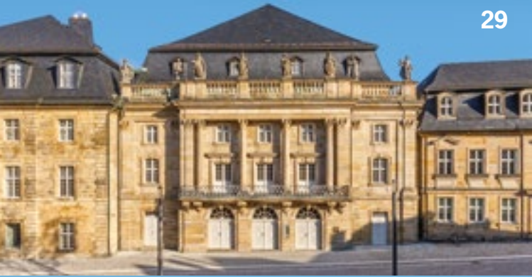
Fassade des Markgräflichen Opernhauses
