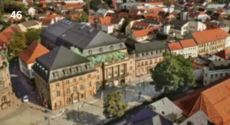
Luftaufnahme des Markgräflichen Opernhauses
