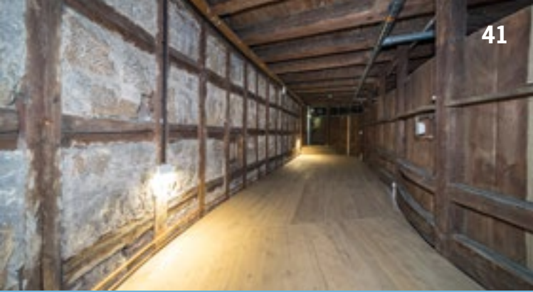
Rückseite der Logenhauskonstruktion
