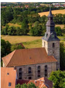
Bayreuth, St. Johannis (Stadt Bayreuth, DB Bayreuth-Bad Berneck) ehem. Chorturmkirche des 15. Jh. (mit Vorgängerbauten): Langhausneubau 1741-45 , Architekt J. D. Rantz, Ausführung: Maurermeister J. N. Ulsch. Doppelempore im Norden und Süden, im Westen Orgelempore, Kanzelaltar 1743 von J. G. Rantz, Schreinerarbeiten von J. J. Müller, Fassung 1753 von J. N. Gruner, Taufengel 1758 von J. G. Rantz; Deckenstuck 1775 von M. Krätzer nach Entwurf von J. G. Riedel.
